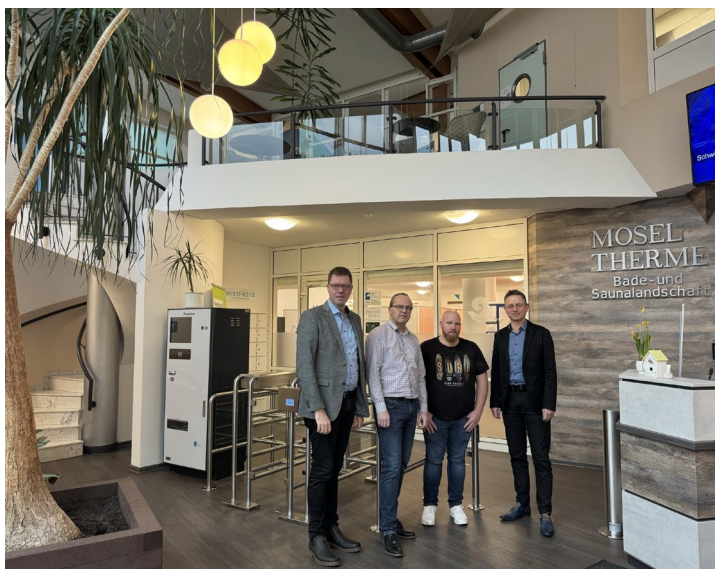
Begutachten die neuen LED-Leuchten in der Moseltherme in Traben-Trarbach (v. l.): Bürgermeister Marcus Heintel, Werkleiter Jens Burch, Betriebsleiter Daniel Schön und Westenergie-Regionalmanager Marco Felten. (Foto: Westenergie AG / Theresa Knod)
